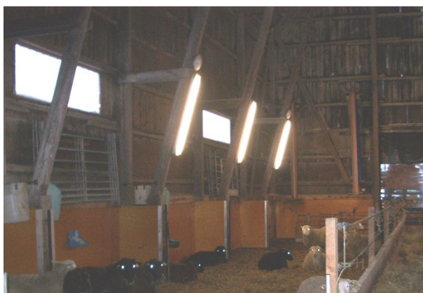
Två exempel på hur man kan lösa uppsättningen av lysrör i lokaler med högt i tak.
